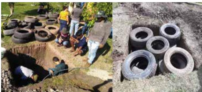
Figura 04 – Etapa da argamassa e construção da caixa de gordura.
