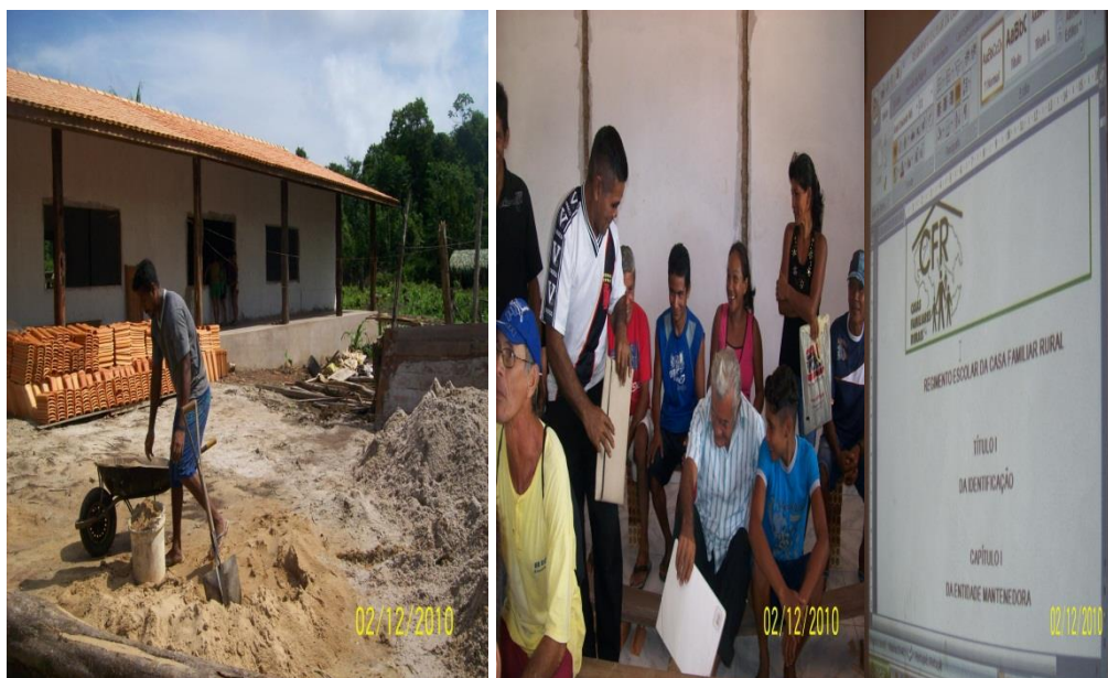
Figura 6: Construção da Casa Familiar Rural
