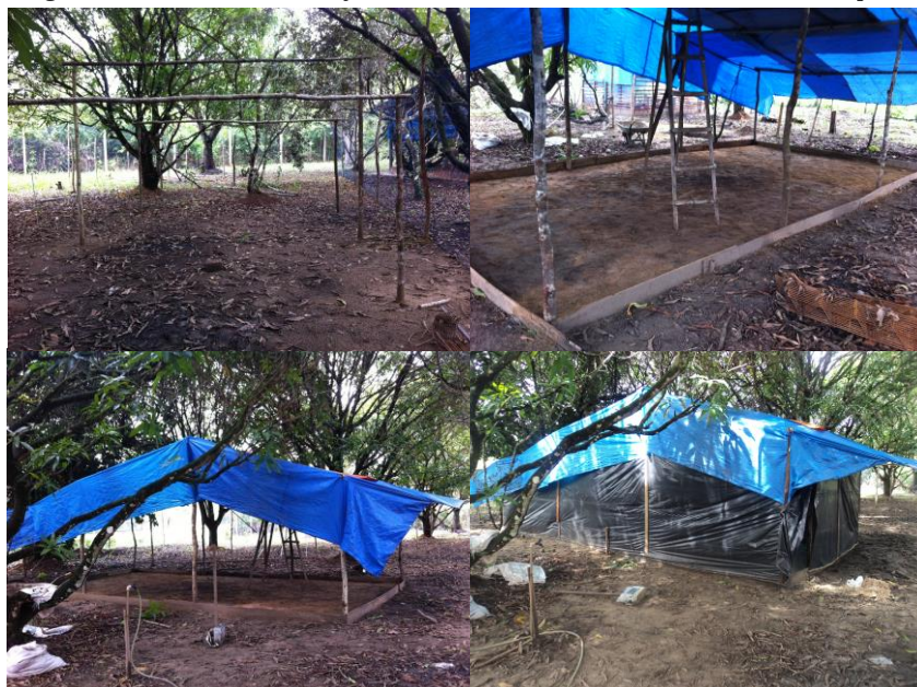
Figura 05. Fases da construção do aviário alternativo no Sítio Julieta Siqueira
