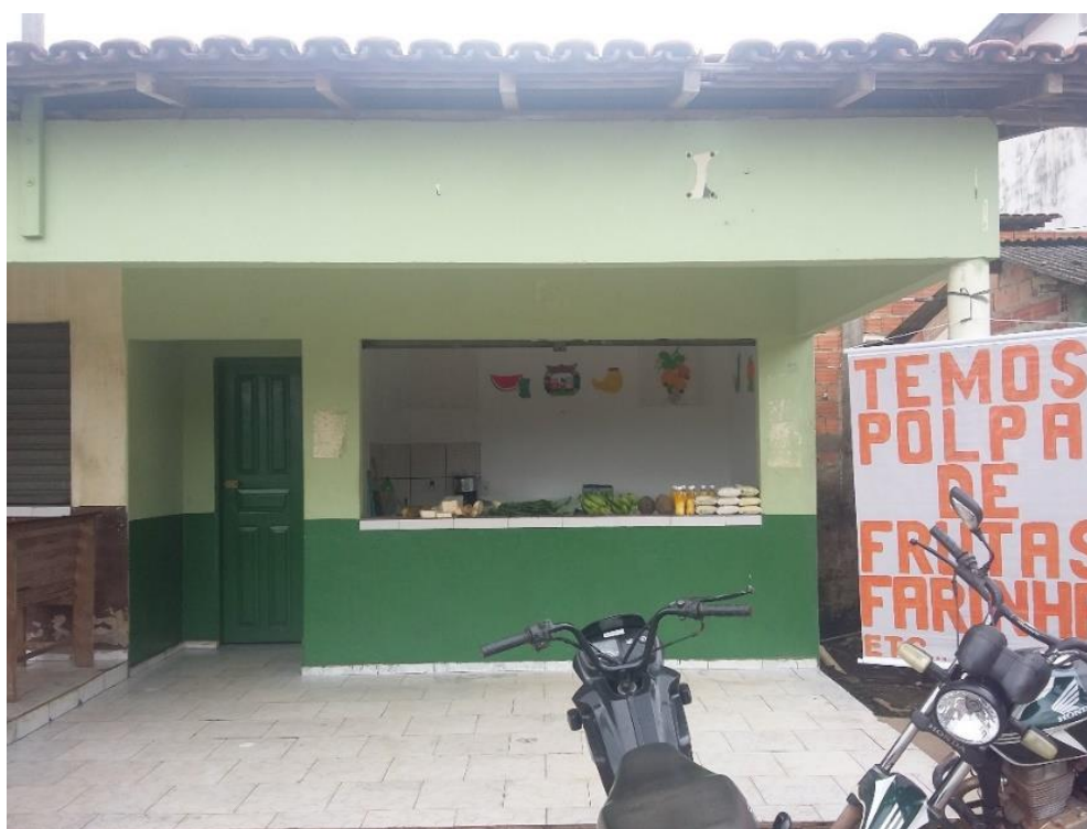
Foto 4: Quiosque de vendas dos produtos da Cooperativa, ao lado do Mercado Municipal de Irituia.
