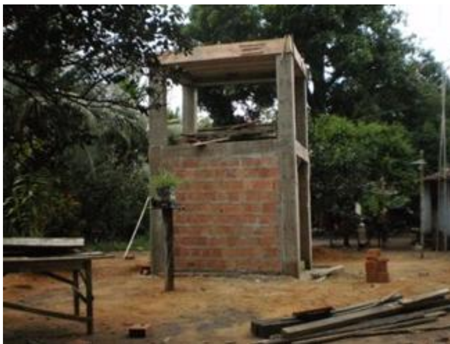
Figura 4 – Reservatório de água do Sr. Manoel Marins. Fotos: acervo próprio.
