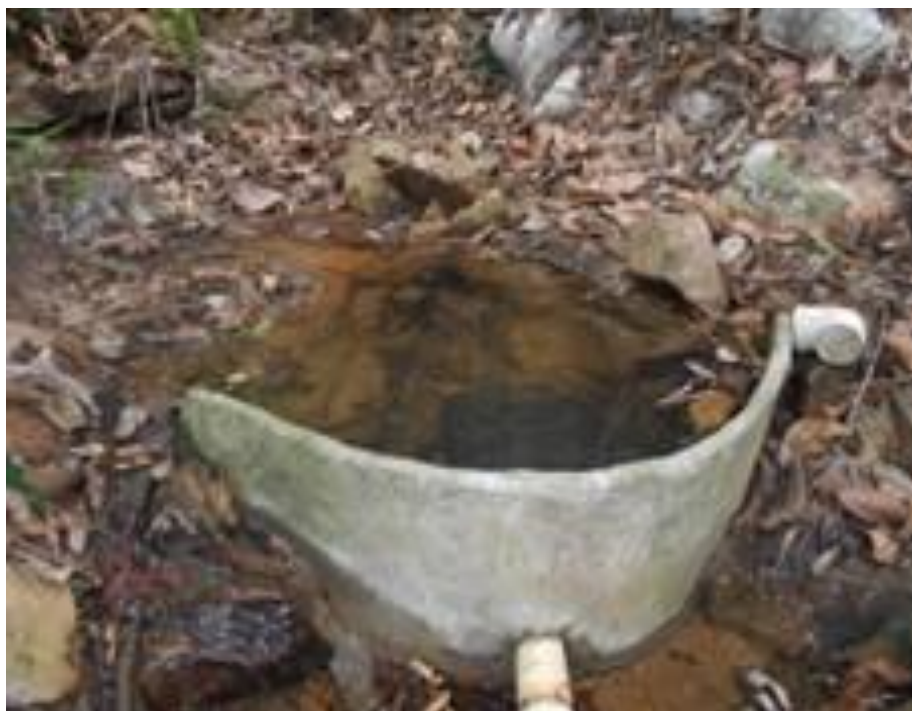
Figura 6 – Contenção para captação de água por gravidade IALA. Fonte: Acervo próprio
