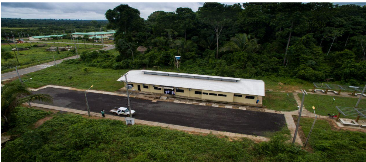
Imagem 7- Prédio do DASCA- maio de 2017
