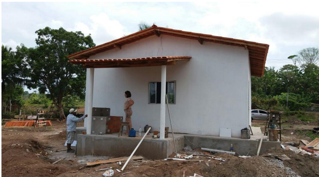
Figura 08 – Sala de Polpa construída
