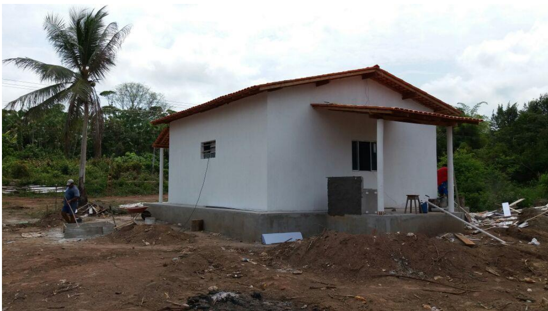
Figura 05 – Construção da Sala de polpa
