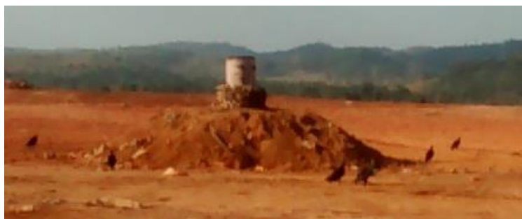
Figura 11 – Imagens da área de compactação do Aterro - No centro o exaustão
