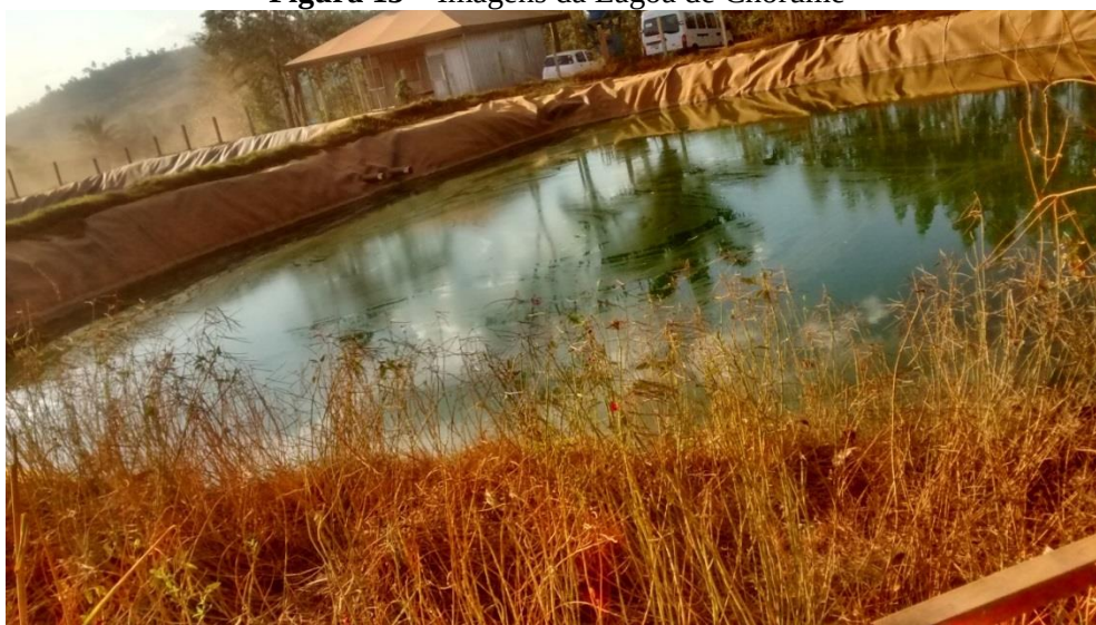
Figura 13 – Imagens da Lagoa de Chorume
