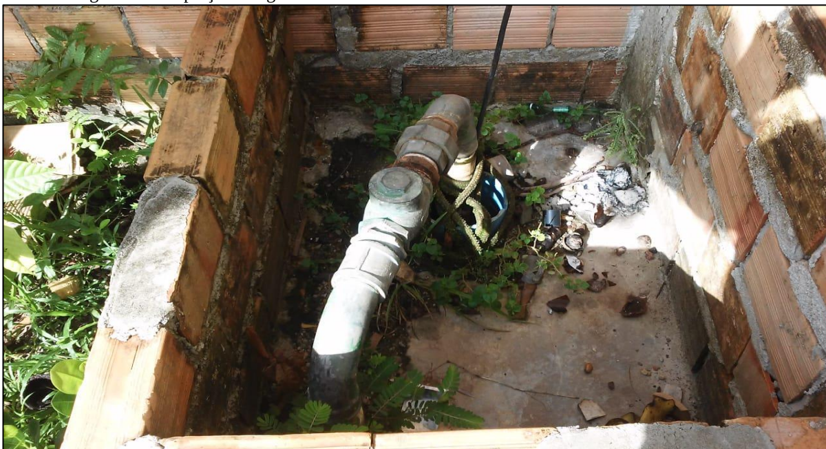
Figura 23 – Captação da água em sua forma bruta é imediatamente distribuída às residências.
