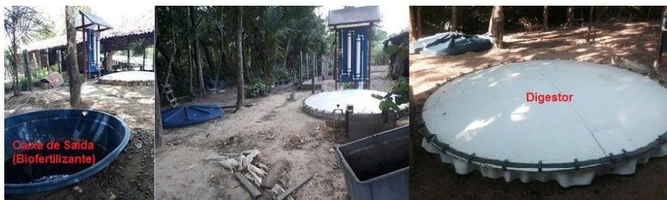
Figura 2.3: Biodigestor modelo marinha com adaptações.
