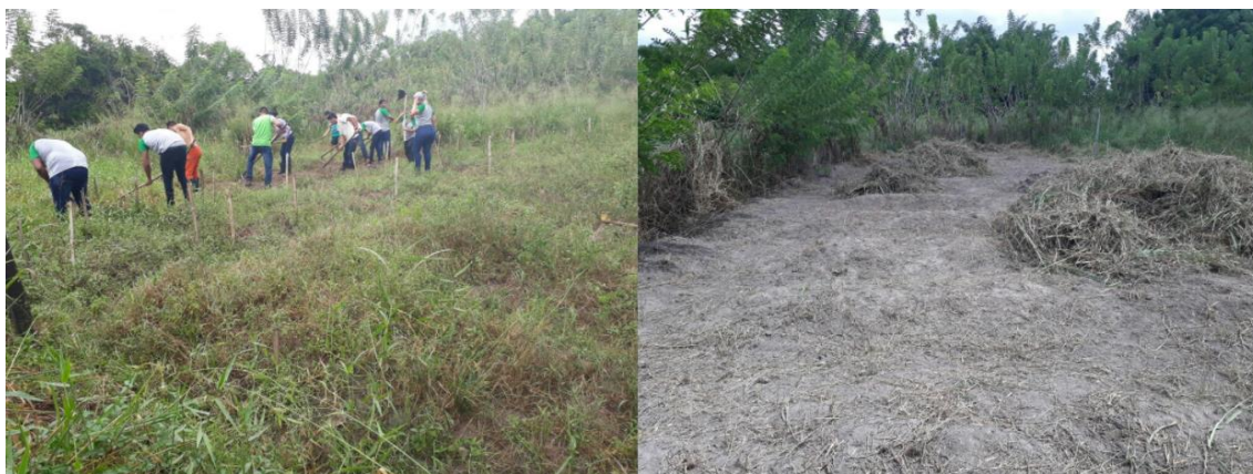
Figura 3.2: Limpeza da Área.
