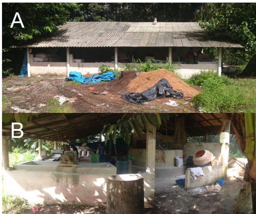
Figura 5. Casa de Farinha da agrovila do Pacuquara, A: visão geral do empreendimento e B: visão lateral, distrito do Apeú, nordeste paraense, Pará
