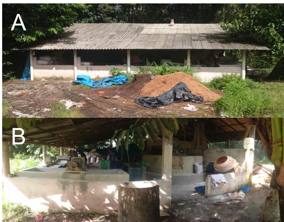
Figura 2. Estrutura física da Casa de Farinha da agrovila do Pacuquara, A: visão geral do empreendimento e B: visão lateral, distrito do Apeú, nordeste paraense, Pará
