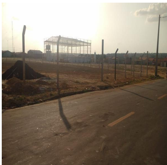
Figura 14 – Área para construção da horta
