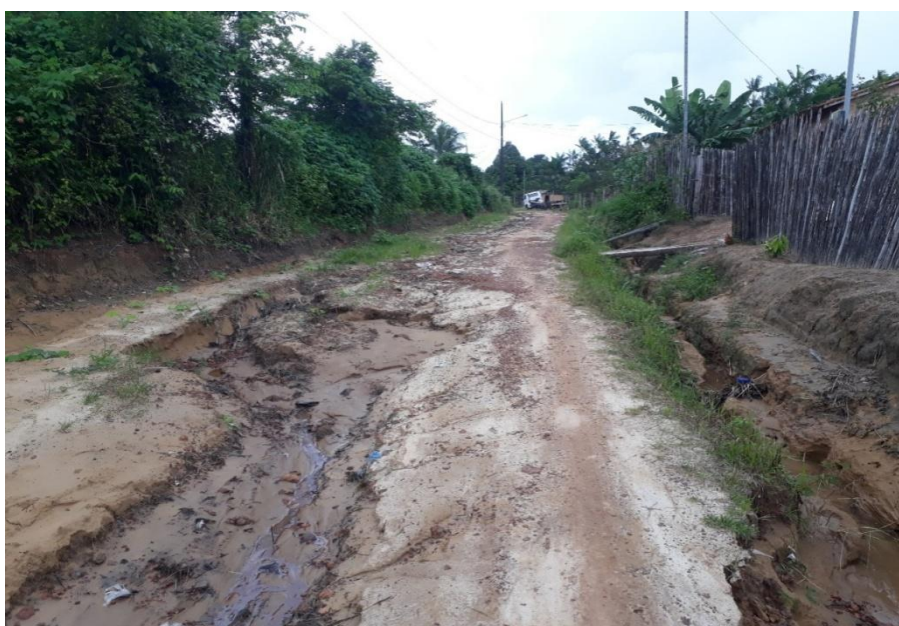
Foto 2 - Rua dentro da comunidade Segredinho.
