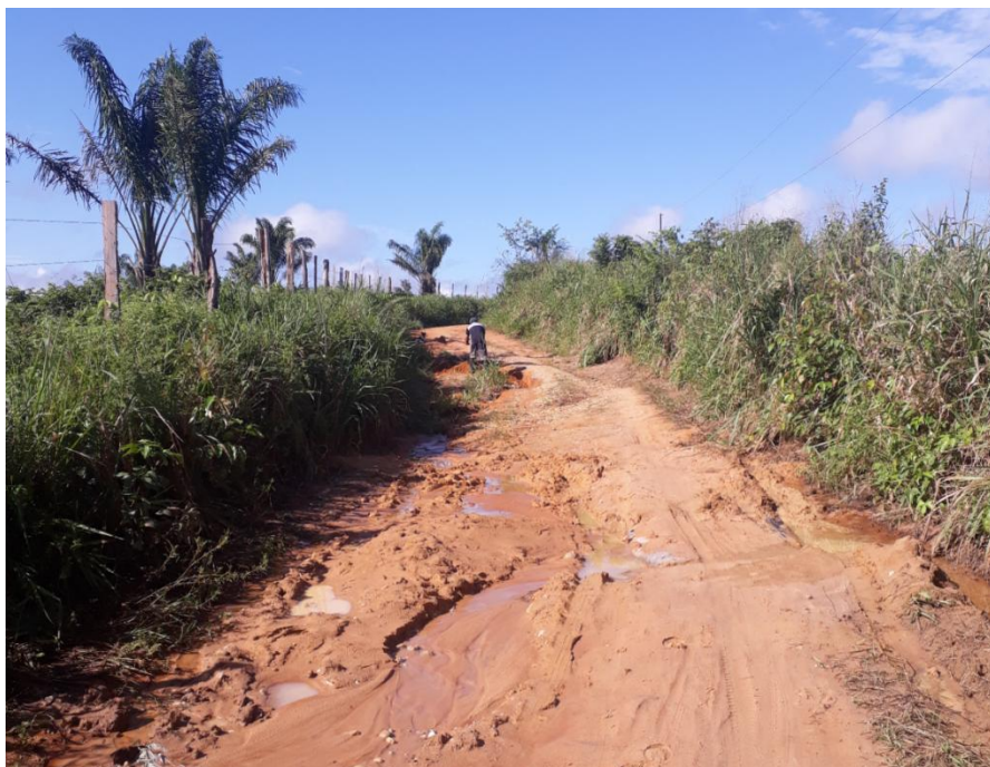
Foto 3 - Estrada de acesso a parte mais interna da comunidade Igarapé Apra onde pode-se ver um morador local tentando tapar os buracos.
