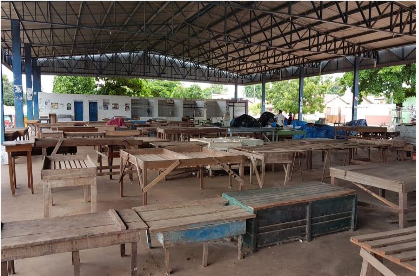
Figura 5: Foto da Feira Coberta parte interna
