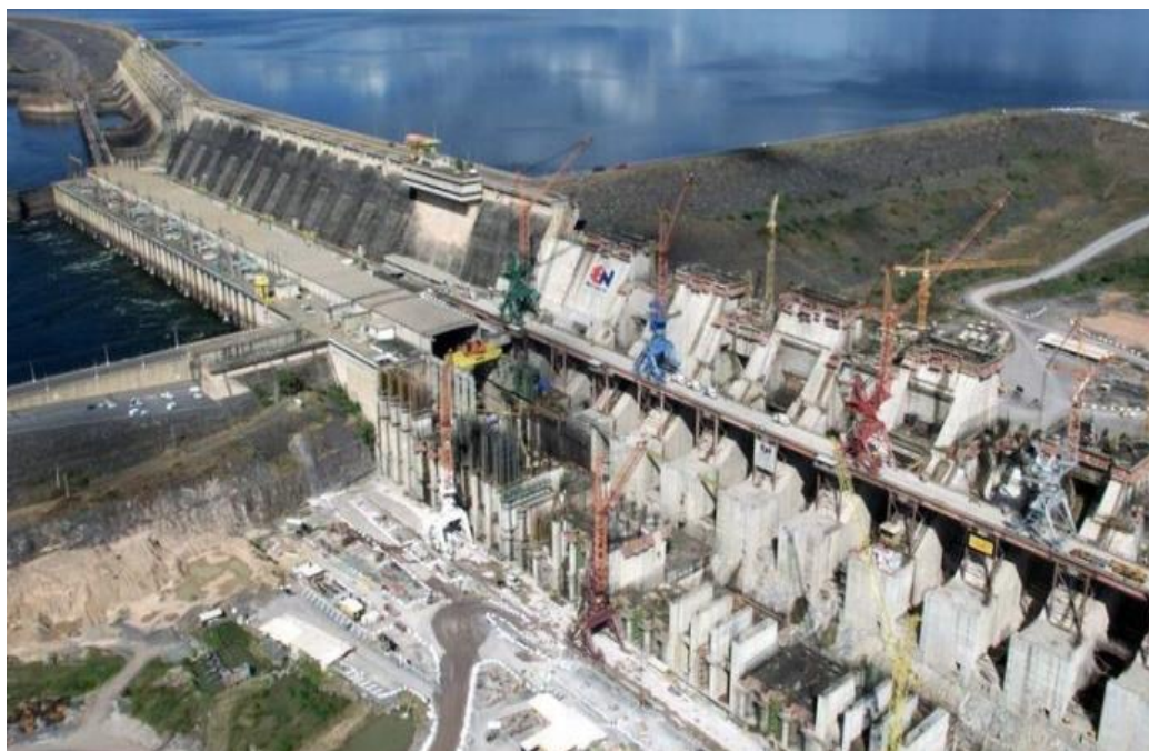
Figura 2: Construção da Hidrelétrica de Tucuruí
