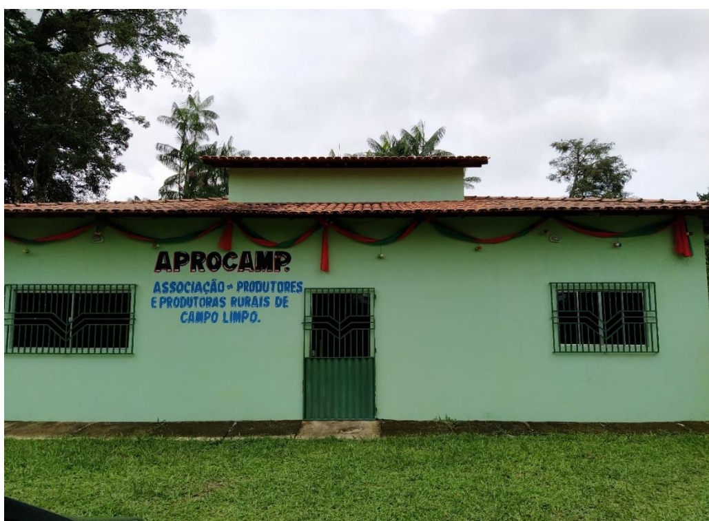
Figura 2. Sede da APROCAMP, Comunidade Campo Limpo.
