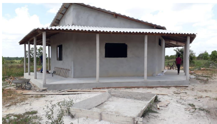
Figura 8 – Casa do Mel em construção
