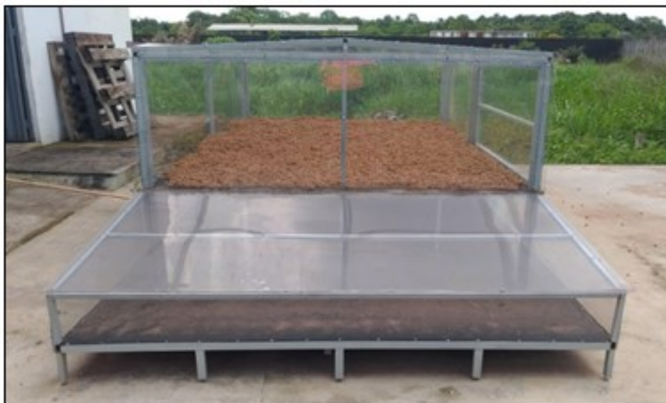
Figura 12. Estufa de secagem de alto rendimento construída de policarbonato.
