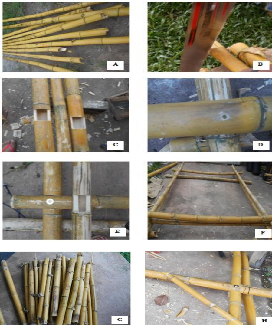
Figura. Confecção da estrutura de sustentação. Legenda. A e B- Bambus medidos e cortados; C, D e E- Encaixe das varas de acordo com a largura do bambu; F- Estrutura pronta de sustentação; G- Corte das varas menores para confecção da estrutura de encaixe dos carotes; H- Encaixe pronto para colocação das boias.
