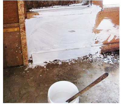
Figura 29: 1 - Limpeza do galpão, 2 - Aplicação de cal virgem no galpão.
