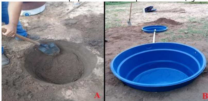
Figura 9. Montagem do Biodigestor.
