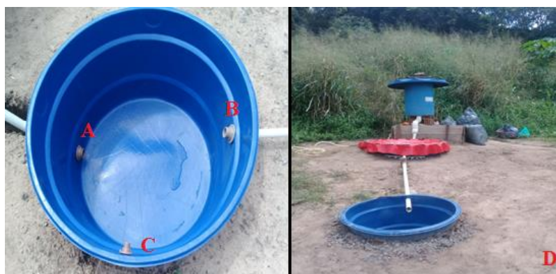
Figura 10. Instalação da Canalização da caixa d'água 500 L. (A: entrada de biomassa; B: saída do biofertilizante; C: saída do biogás; D: biodigestor instalado).
