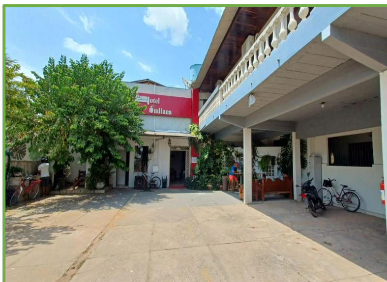
Foto 07: Estacionamento do hotel
